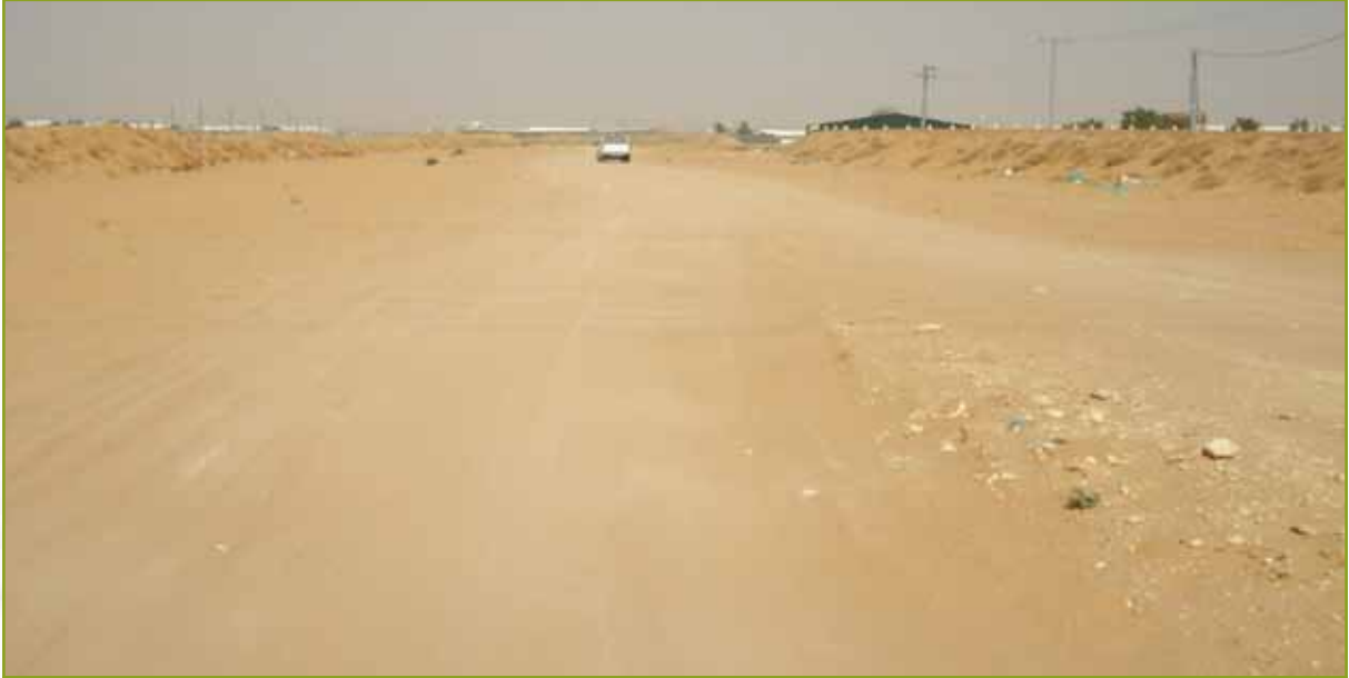
شكل رقم ١٤: قناة سيل فرعية تستخدم كطريق تم حفرها في شعيب البرشاعة، منطقة النظيم.
