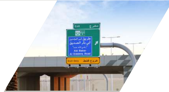
٥٧ لوحة في الطريق الرئيسي لتوجيه المركبات
