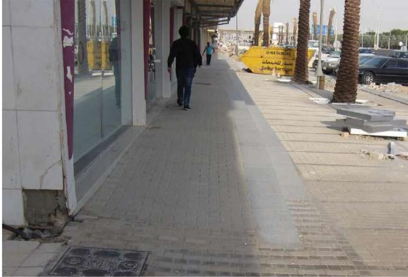
الشكل ٧٢/٥ مدخل متكامل باحذار تدريجي مع درج، يسمح بوصول الكرسي المتحرك إلى وحدات المتاجر. أنظر التفصيل في الصورة التالية
