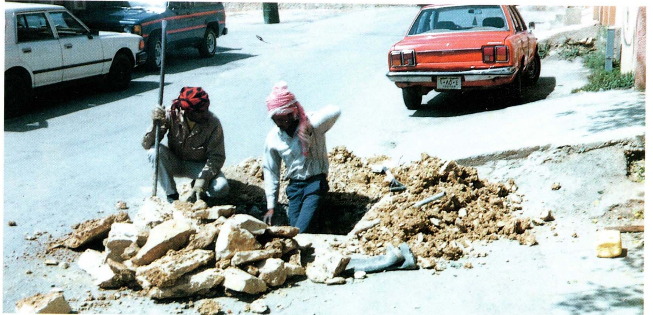
● إصلاح أحد أنابيب شبكة مياه الشرب كمرحلة تلي عملية الكشف عن التسربات في هذه الشبكة.
