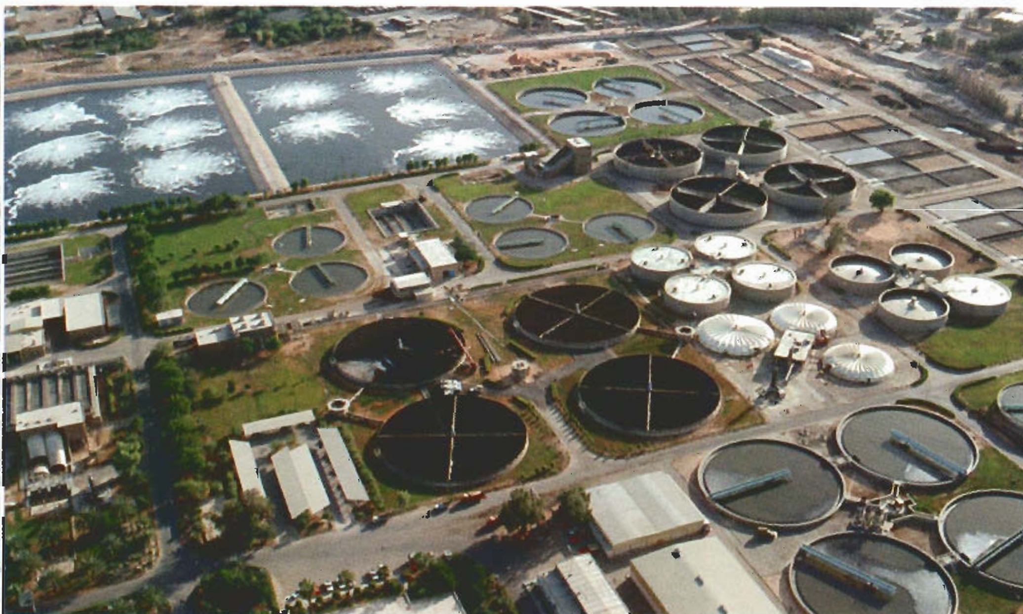
محطة معالجة مياه الصرف الصحي بطاقة تصل لمليون متر مكعب يومياً
