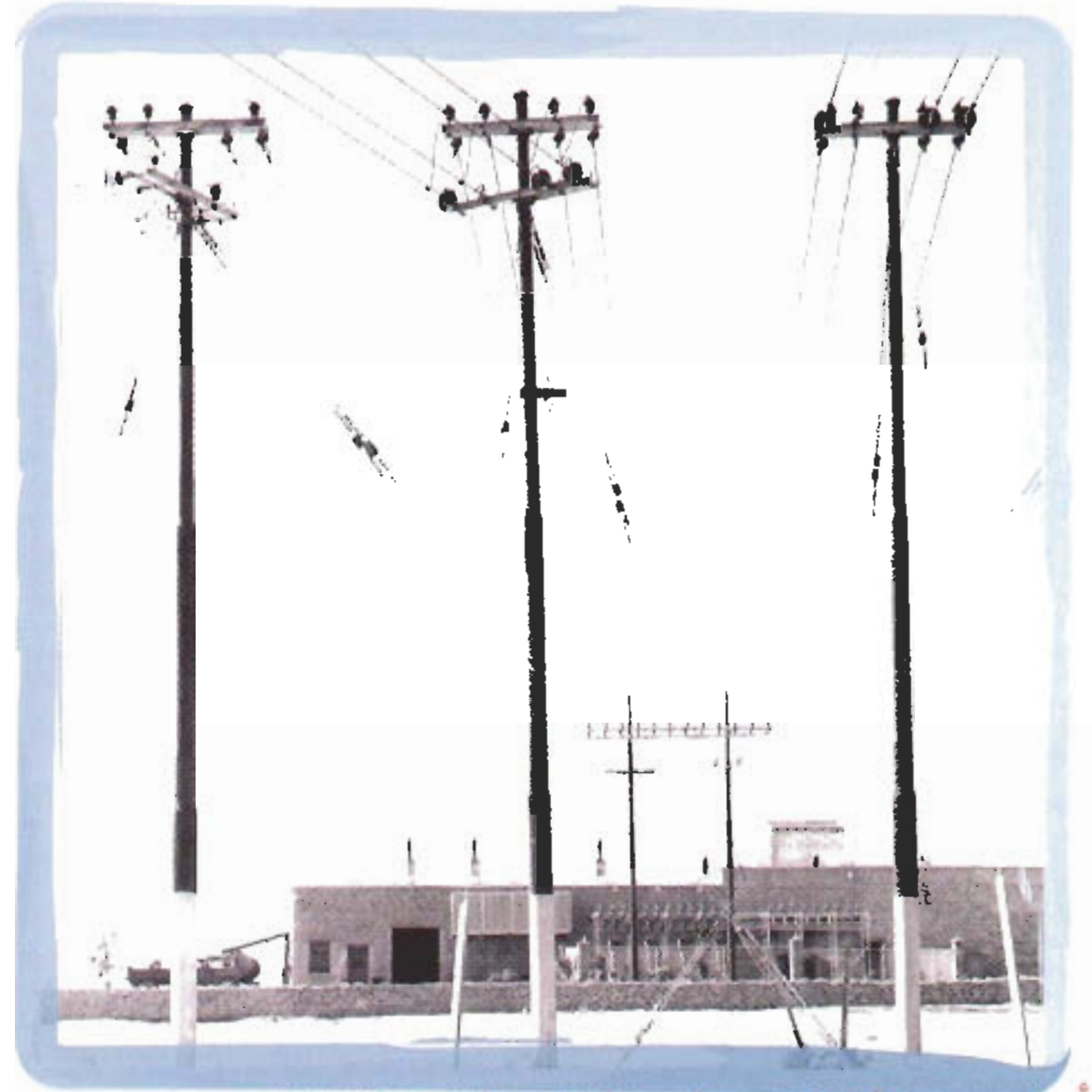
أول محطة كهرباء في الرياض ١٣٧٣هـ
