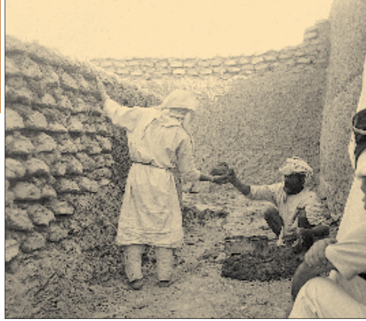
جانب من أعمال البناء باستخدام الطوب الطيني في مجمع قصور المربع عام ١٣٥٧ هـ.
