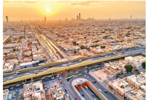
تسارع أعمال تنفيذ المرحلة الثانية من مشروع تطوير طريق أبي بكر الصديق
